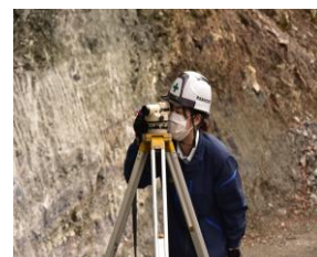
林道工事の現場で測量中
