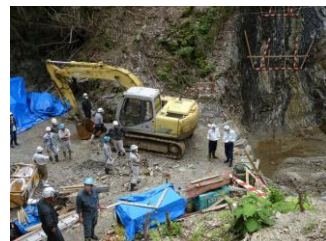
安全パトロールの様子
