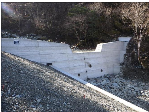
谷止工と護岸工 (三好市東祖谷 樫尾国有林)
