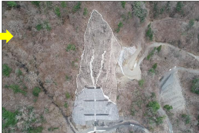
令和4年1月復旧工事完工 (施工工種: 法枠工・鋼製かご枠土留工・水路工・シート伏工外)
