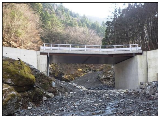
三好市 祖谷山林道笹谷線災害復旧
