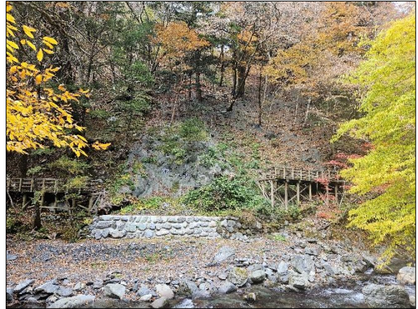
山腹工 (三好市東祖谷 塔の丸国有林)
