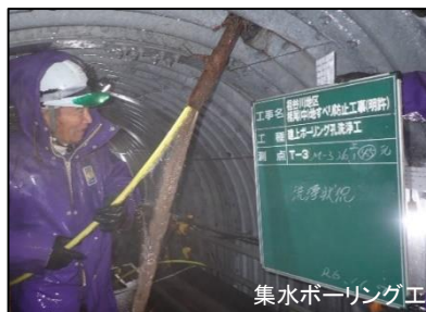
集水ボーリング工
