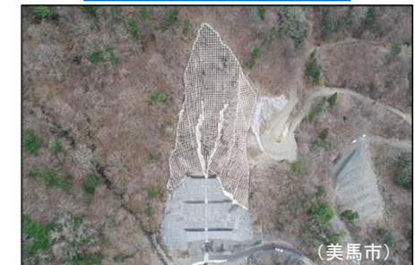
斜面崩壊 復旧状況
