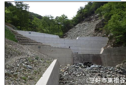
荒廃溪流への谷止工 設置状況
