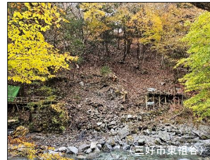
治山対策実施前 全景
