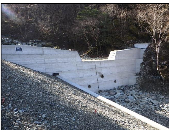
谷止工と護岸工 (三好市東祖谷 樫尾国有林)
