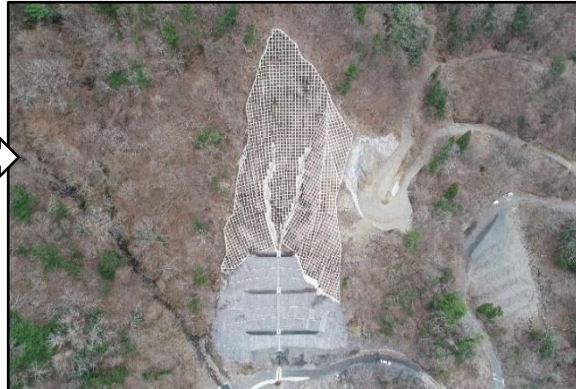
令和4年1月復旧工事完工 (施工工種: 法切工・鋼製かご枠土留工・水路工・シート伏工外)
