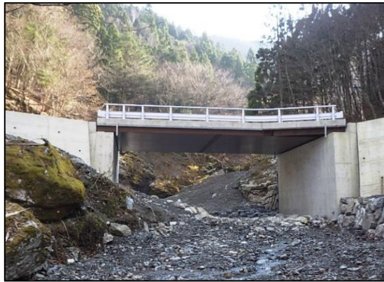
三好市 祖谷山林道笹谷線災害復旧
