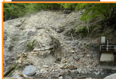
電力取水施設 被害状況
