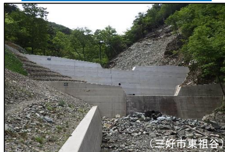
荒廃溪流への谷止工 設置状況
