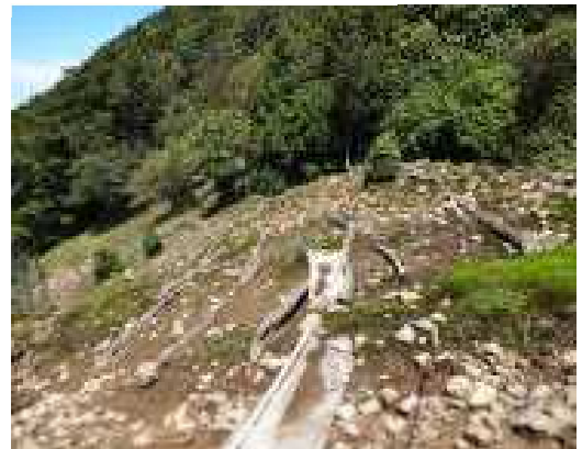
シカ防護ネット柵設置前
