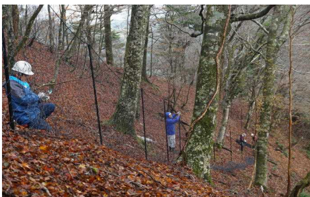
シカ防護ネット柵設置中
