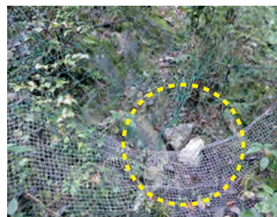
編み目の小さいネットに落石
