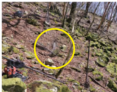
土砂等の堆積による被害
