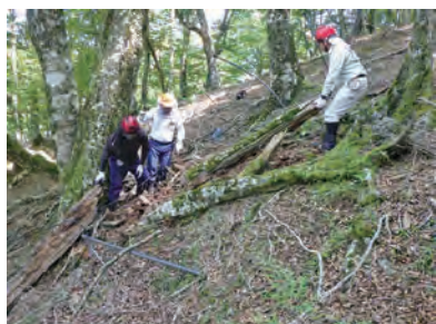
枯損木で倒壊したシカ防護柵
