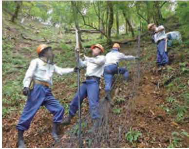
支柱再建と張り直し
