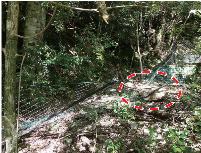
落石でネット柵が損壊
