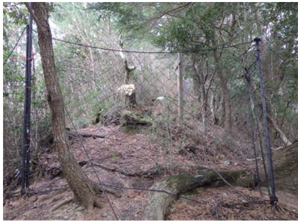
シカ防護ネットの設置状況①
