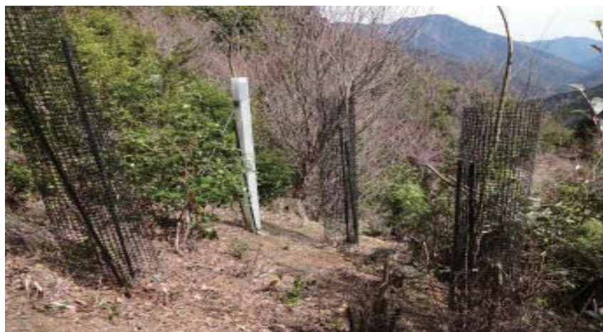
状況に応じてヘキサチューブを取り外しラス巻きに切り替え中
