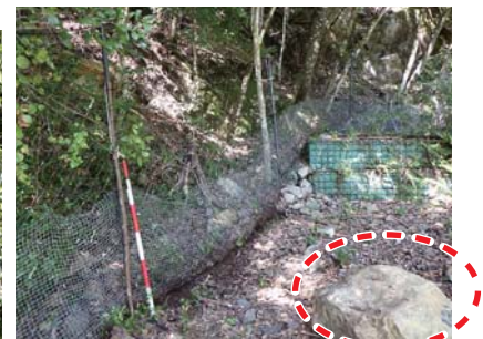
石を撤去しネット柵の補修
