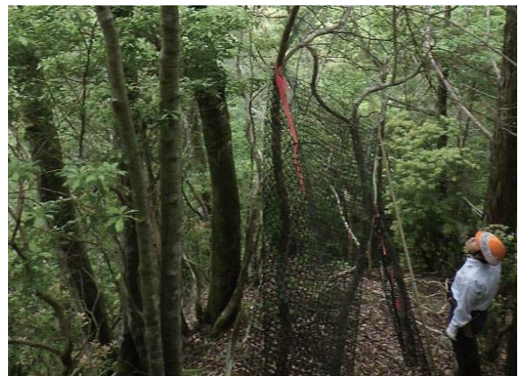
ラス巻きの設置状況
