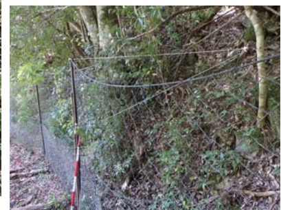
ネット柵の補修後
