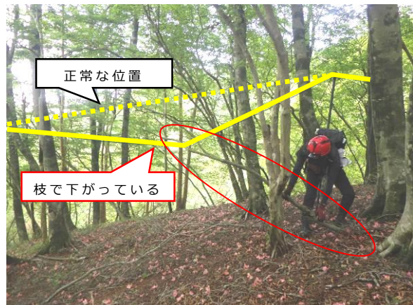
防護ネット柵にかかっている枝を撤去
