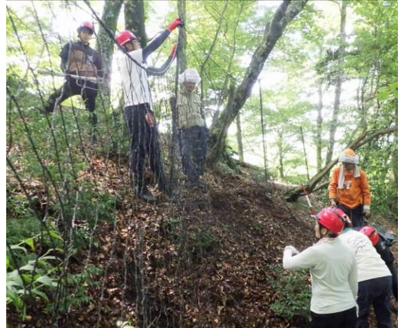
折れていた支柱の交換作業
