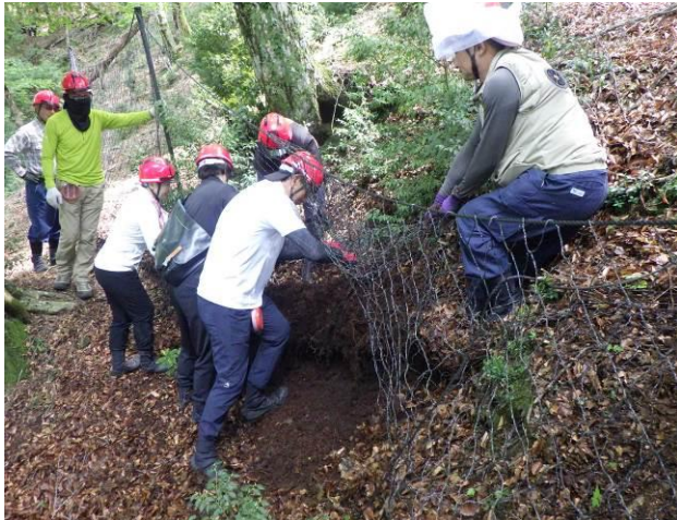
落ち葉等で埋もれたネットの掘り出し
