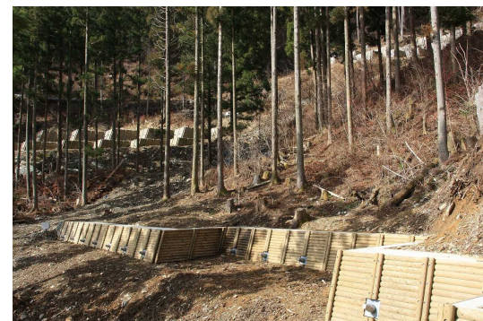
写真2 長又地区抑止工(アンカー工)
