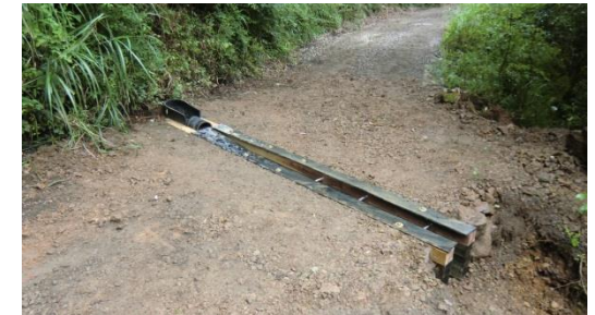
【図3 流路傾斜型木製横断溝の設置の様子】
