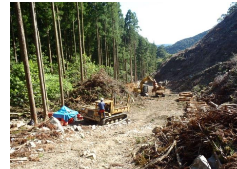
枝条・低質材 貯材状況
