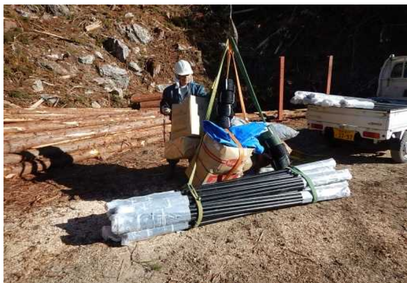
架線によるシカ防護柵の運搬
