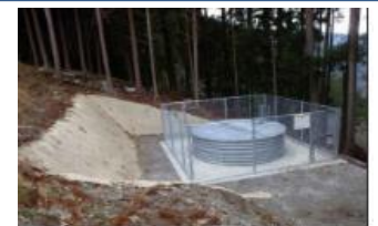
治山工事（徳島署）
