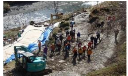
森林土木事業における ICT 施工の現地 検討会（徳島署）
