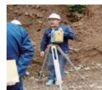
ICT施工現場視察及び 現地検討会（局）
