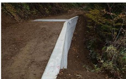
林道改良（災害復旧）
