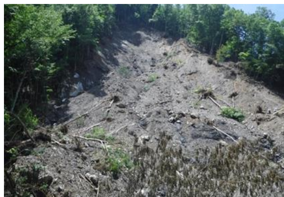
地上からの撮影は視点が低いため、全体の被害状況の確認は難しい。
