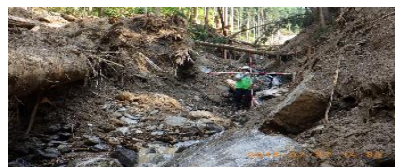
7月豪雨災害の被災地における山地災害対策緊急展開チームの調査(愛媛県)
