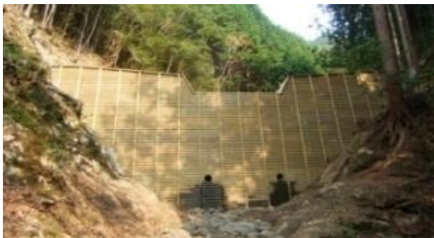
木製型枠を使用した谷止工
