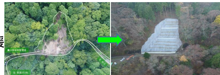
間伐材等を使用した山腹工の実施(香川所)
