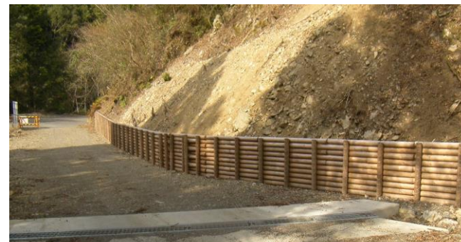
林道に施工した木柵工
