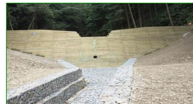
間伐材等を使用した溪間工(愛媛署)
