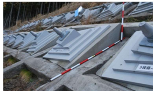
写真 2 アンカー工施工箇所
