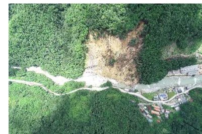
写真 1 三好市白川区域崩壊地全景
