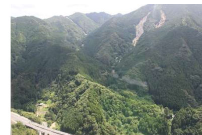
写真 2 大豊町立川下名区域崩壊地全景
