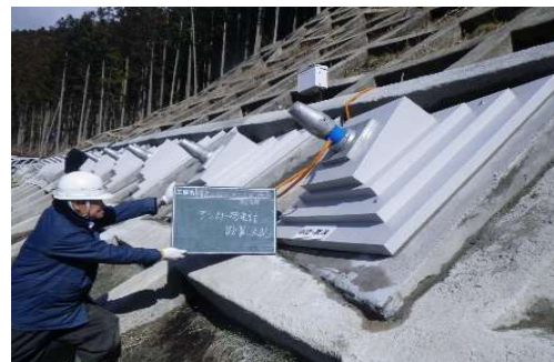
写真 3 荷重計設置状況
