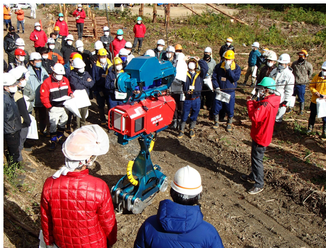
油圧集材機・架線式グラップル実証試験
