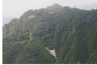
仁尾ヶ内山 ～土砂流出崩壊防止～
