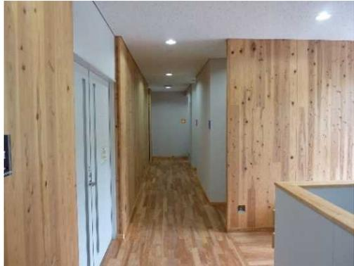
CLT内壁と床サクラ材(2階)
