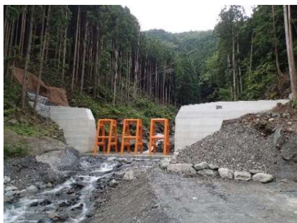
復旧状況(崩壊下流部対策工)
