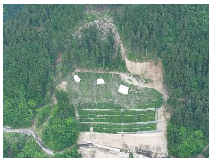
復旧状況(山腹工施工)
