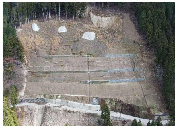
山腹工施工状況（徳島県三好市山城町）
