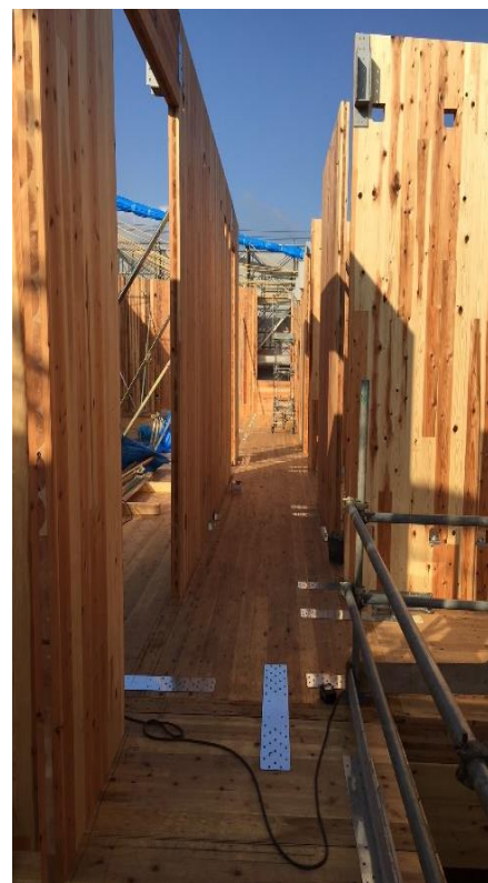
CLTの使用状況(2階)
