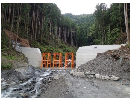
復旧状況(崩壊下流部対策工)
