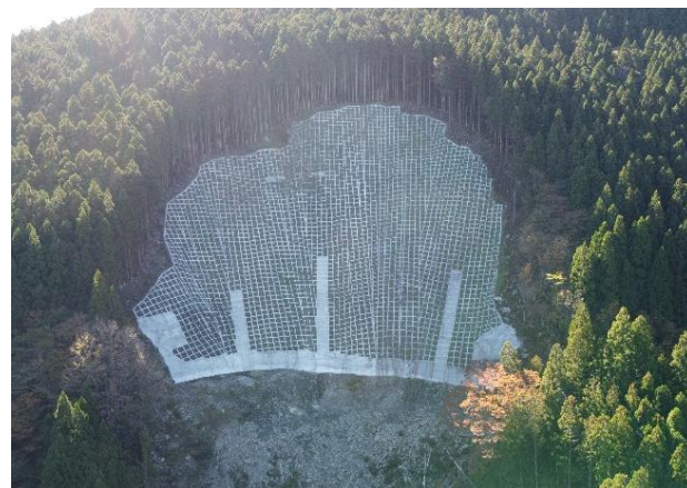
山腹工施工状況（大豊町仁尾ヶ内）
