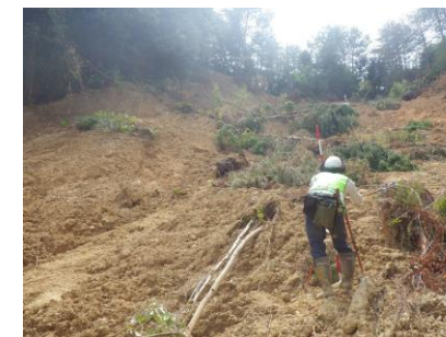
測量作業の様子(愛媛県大洲市)
