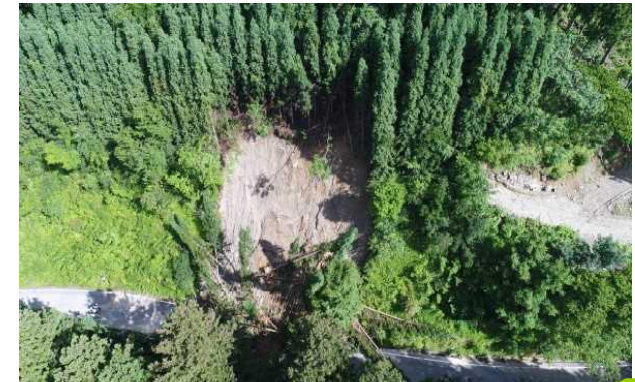
愛媛県内子町の林地崩壊の空撮画像 (H30.7 愛媛森林管理署)
