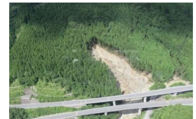
大豊町立川上名の被災現場
