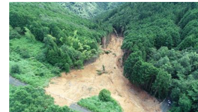
大洲市河辺町の被災現場
