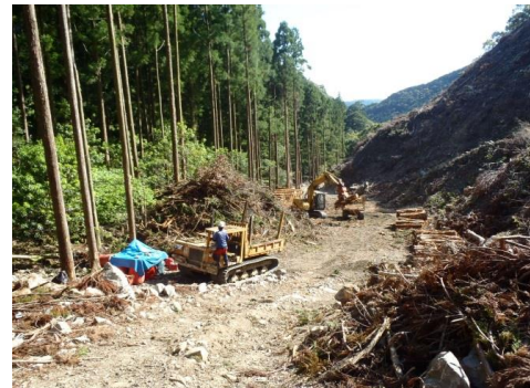
枝条・低質材貯材状況
