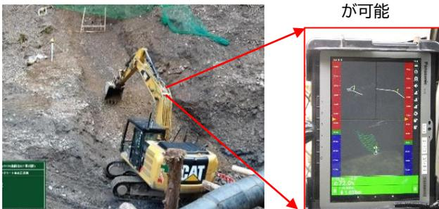
操縦席の端末画面により掘削線の確認が可能
