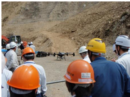
治山事業における大型ドローンを 用いた資材運搬（嶺北署）
