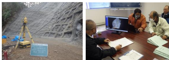
レーザスキャナを活用した出来形計測と検査 (四万十署)
