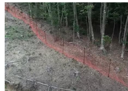
獣害防護柵の巡視
