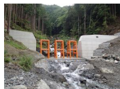
吉野川上流地区仁尾ヶ内(上) 復旧治山工事 (明治建設(有))
