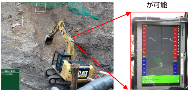
ICT施工(安芸署)
