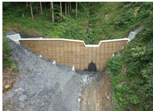
木製型枠を使用した 治山ダム
