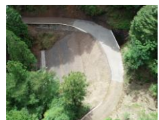
西又東又林道 災害復旧工事 (魚梁瀬産業(有))
