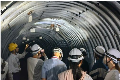
現地説明会（排水トンネルの見学）
