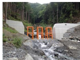
復旧治山工事
