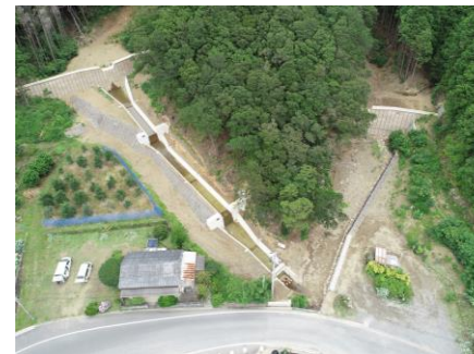
国有林直轄治山事業（弦場山国有林） （高知県大月町）
