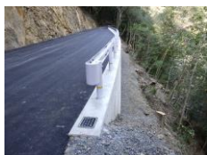
奥藤林道 改良工事 (株)井原組
