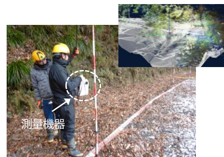
LiDAR※機器による林道災害調査 (高知中部署)
