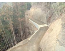
長滝林業専用道 新設工事 (湯浅建設(株))
