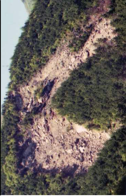
被災状況：栗輪谷区域山腹
