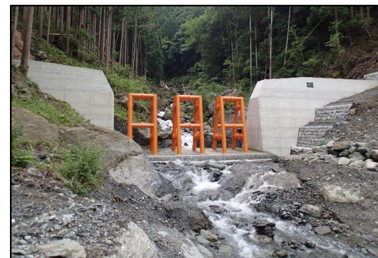
治山ダム（スリット谷止工）施工状況（令和5年）
