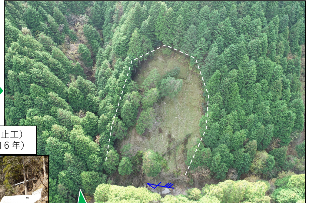
山腹工（航空実播工）施工状況 2年経過（令和6年）
