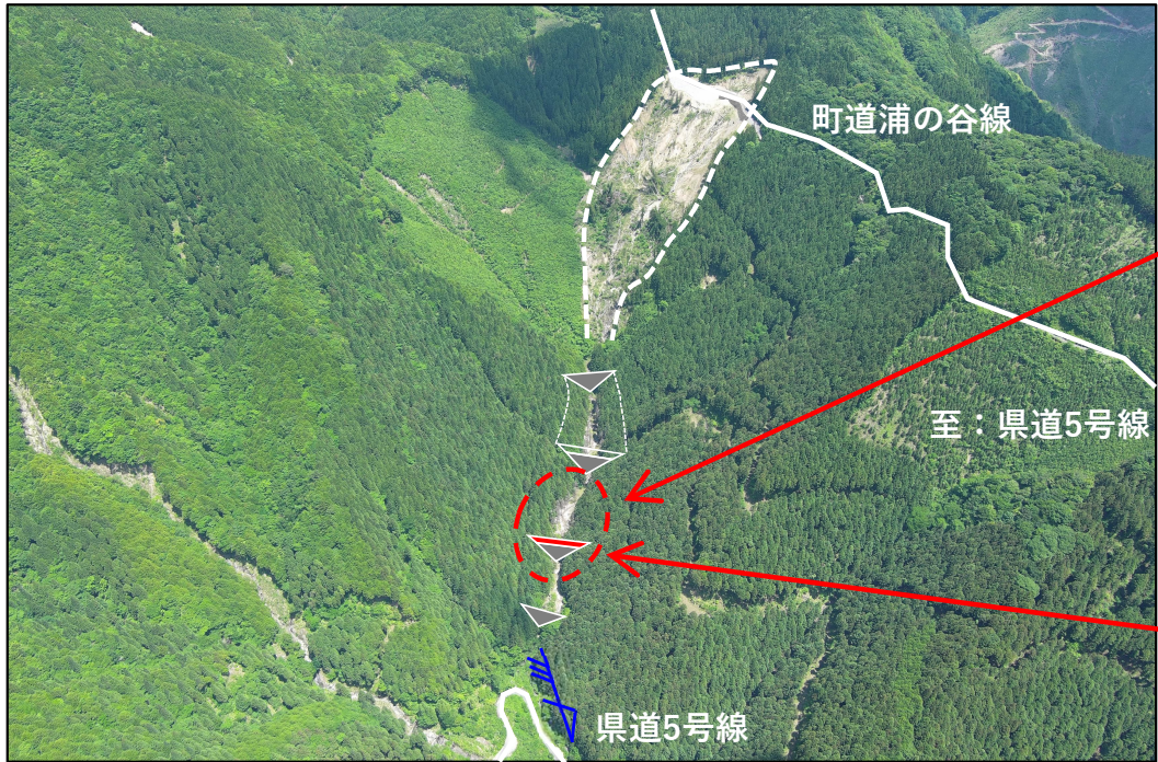
浦の谷区域 山腹崩壊地全景
