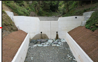
治山ダム（谷止工）等 施工状況（令和6年）
