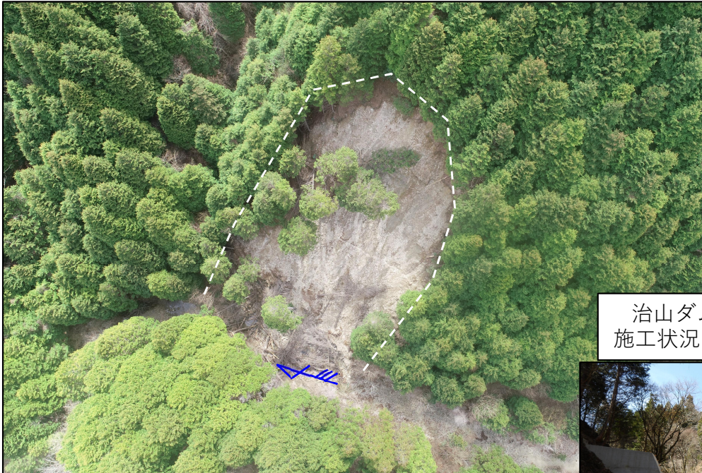
栗山区域 山腹崩壊地全景
