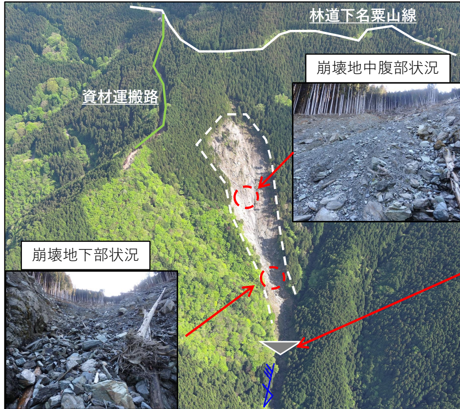
大池区域 山腹崩壊地全景
