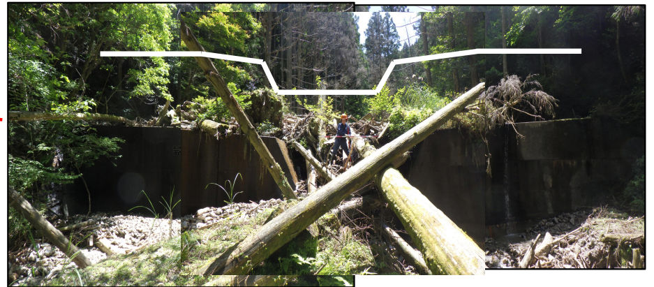
既設治山ダム コンクリート嵩上工 施工中（令和8年）
