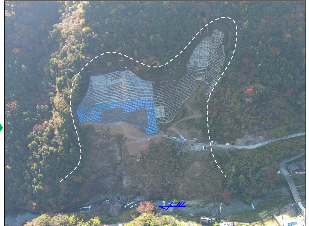
山腹工（法枠工）施工状況（令和7年）
