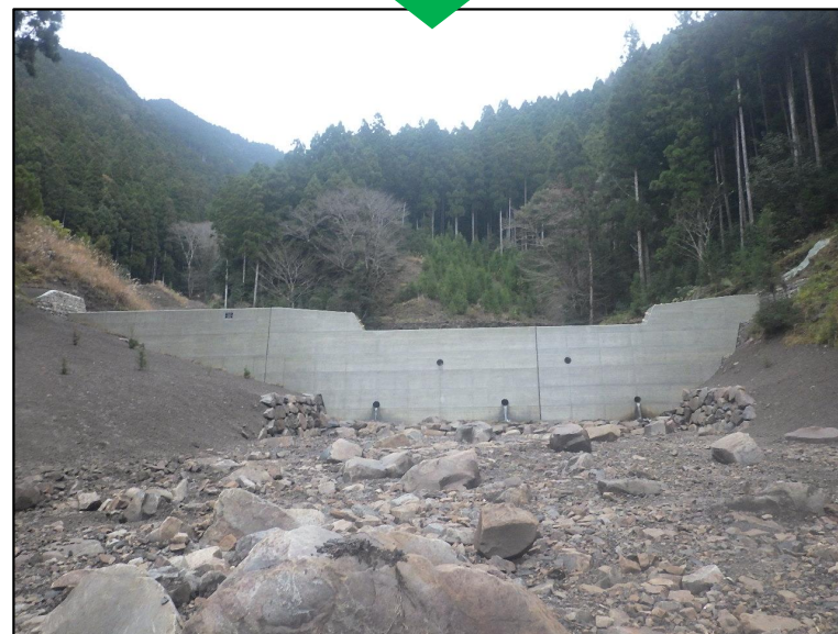
コンクリート谷止工 施工状況 (令和5年)
