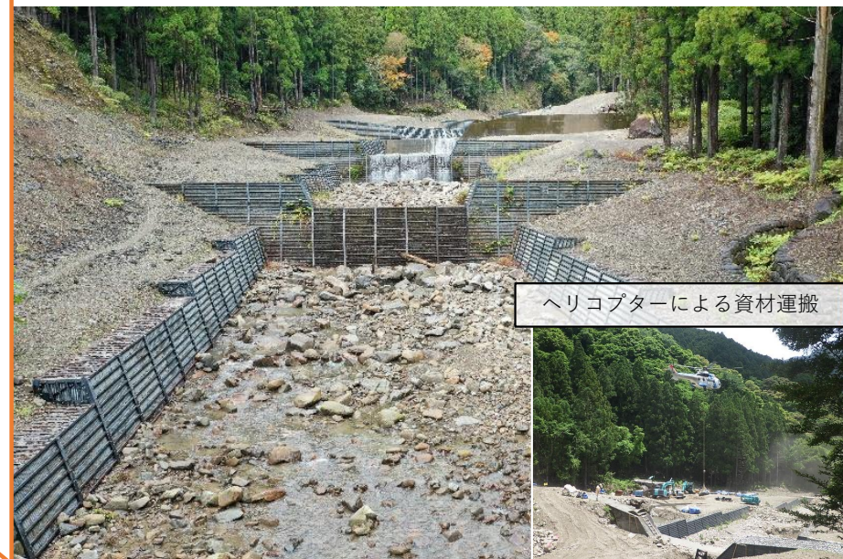
鋼製自在枠谷止工等 施工状況 (令和4年)
