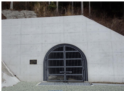
地下水排除工 (排水トンネル工)
