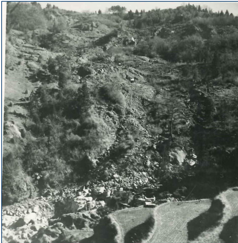
昭和 2 9 年 豪雨による被災状況
