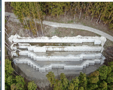
抑止工（アンカー工）
