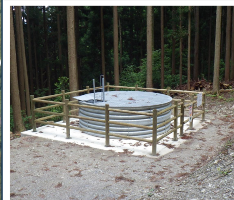
地下水排除工（集水井工）
