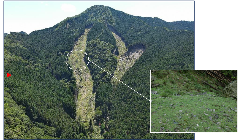
上流部 航空実播工 施工状況（令和6年）
