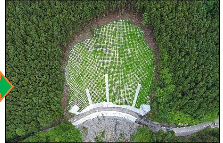
上流部 のり枠工 施工状況（令和5年）
