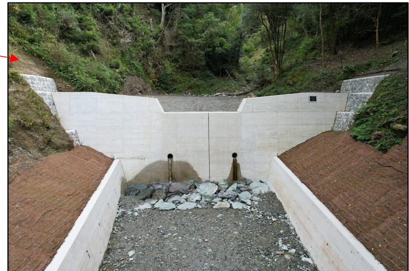
下流部 谷止工 施工状況（令和6年）
