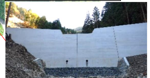
下流部 谷止工施工状況 （令和4年）
