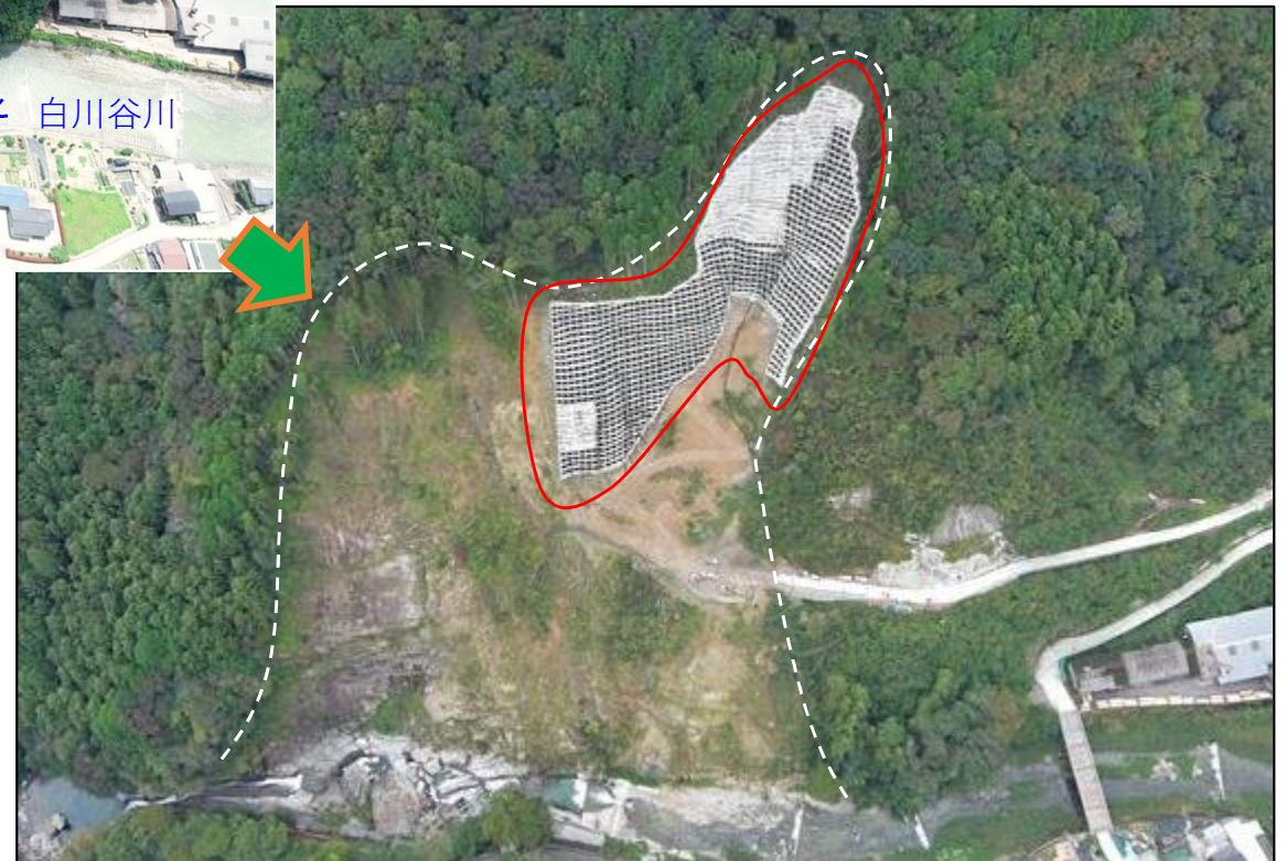
山腹工（一部）施工状況（令和6年）
