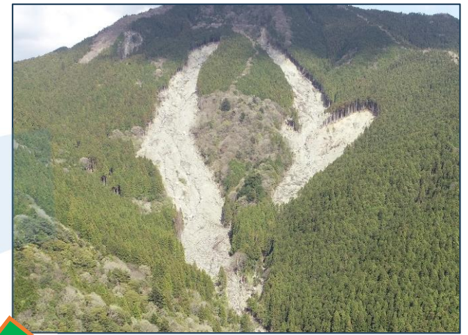
被災状況（令和2年7月）
