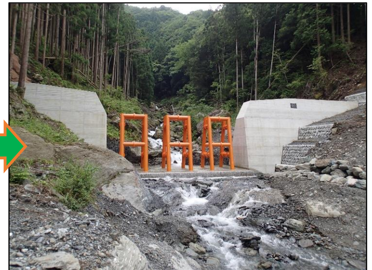
下流部 スリット谷止工 施工状況（令和5年）
