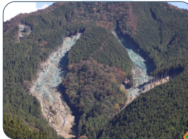
施工後（令和4年10月）
