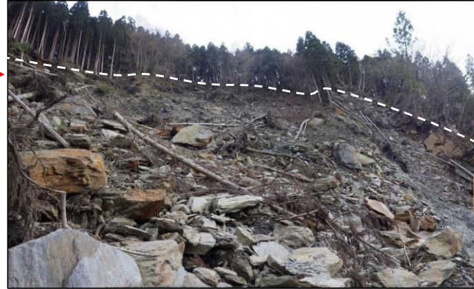
崩壊地上部斜面荒廃状況
