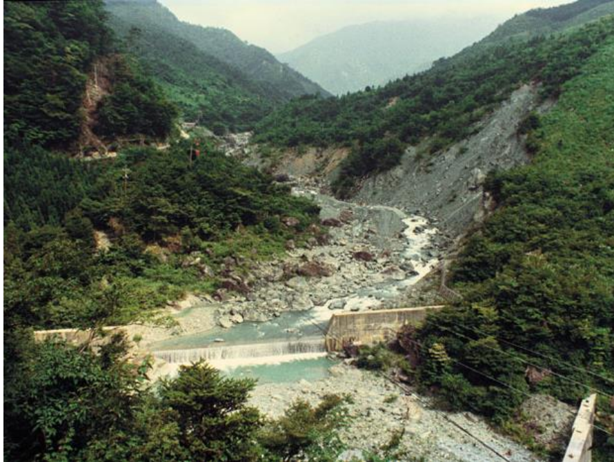
昭和39年 荒廃溪流状況
