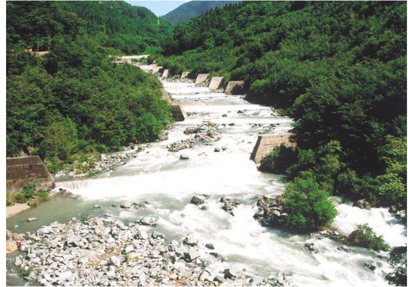
平成10年 床固工施工状況
