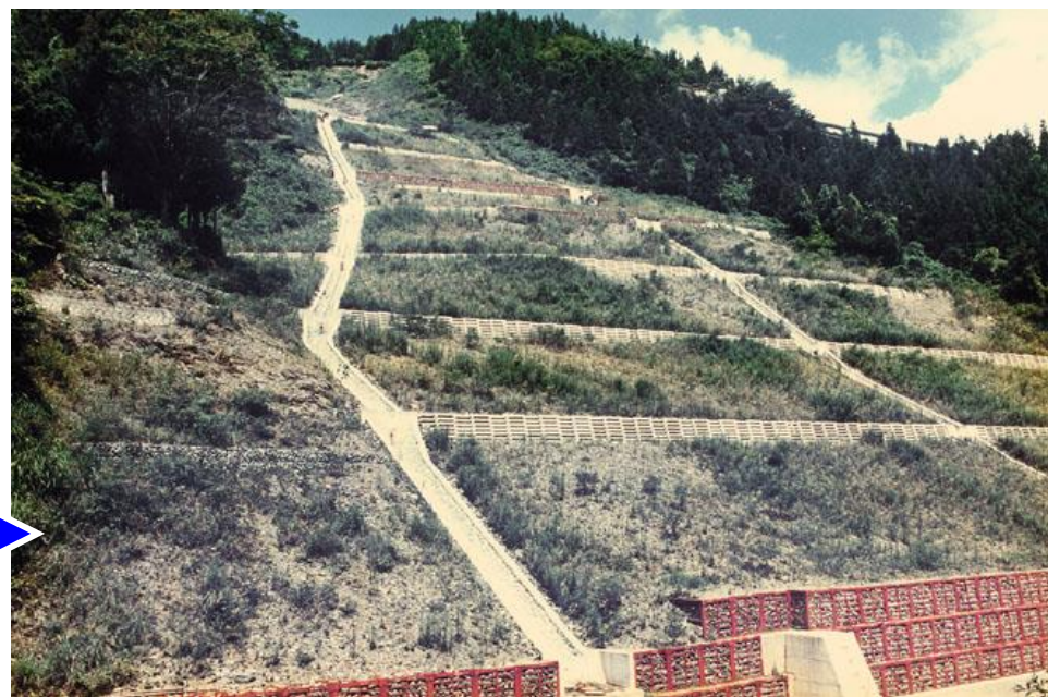
昭和60年 山腹工施工状況
