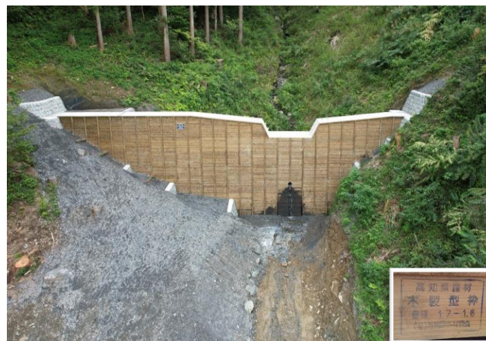
木製型枠を使用した治山ダム 高知県大豊町(吉野川上流地区仁尾ヶ内区域)
