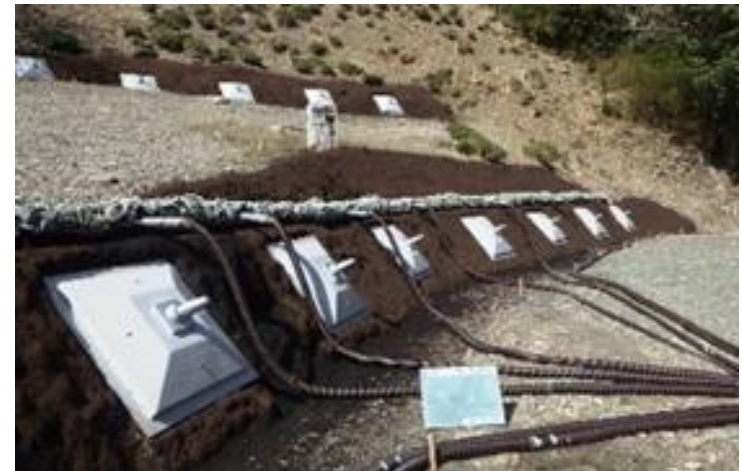
徳島県三好市(祖谷川地区小川下区域)アンカー工
