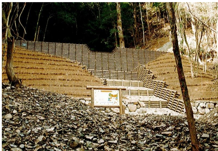
木製治山ダム 愛媛県鬼北町(奈良奥山国有林)
