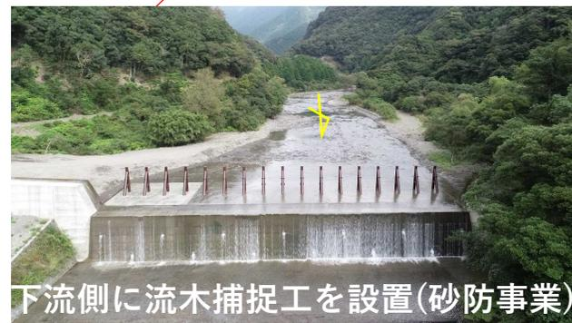
上流域で森林からの流木の発生を抑制しつつ、仮に流木が発生した場合でも下流の施設でこれらを確実に捕捉
