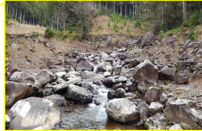
治山ダム 施工前
