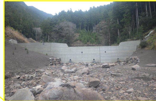
治山ダム（谷止工）施工状況（令和5年）
