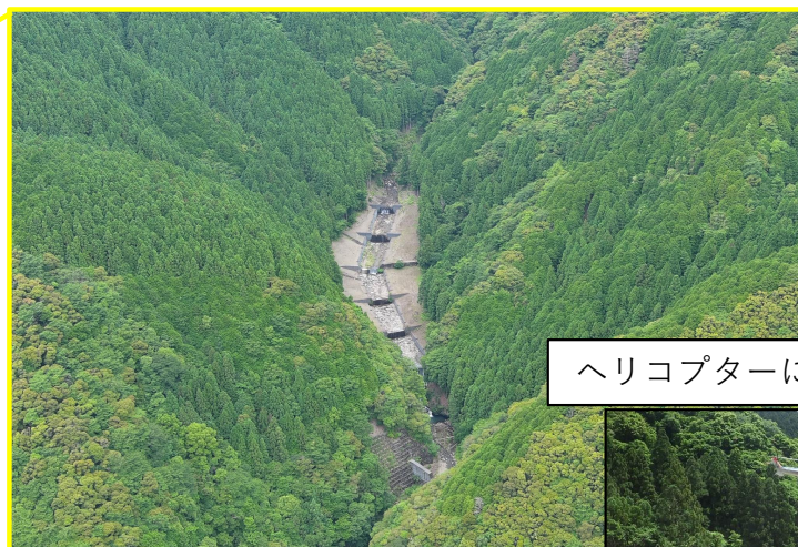
治山ダム（鋼製自在枠床固工等）施工状況（令和4年）
