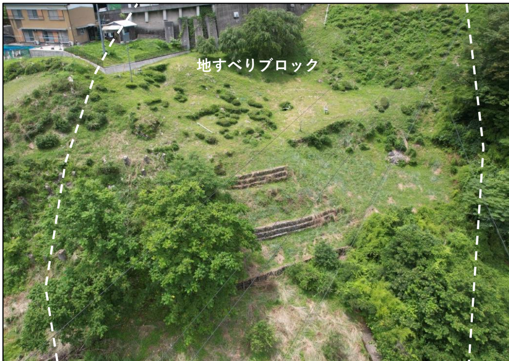
小川区域 地すべりブロック内 地すべり対策工（アンカー工等） 施工前状況
