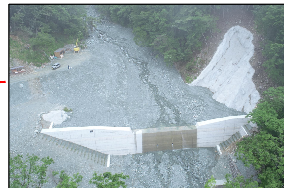
治山ダム(谷止工) 施工状況 (令和5年)
