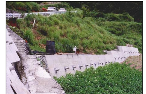
地すべり対策工（アンカー工）施工状況（平成12年）
