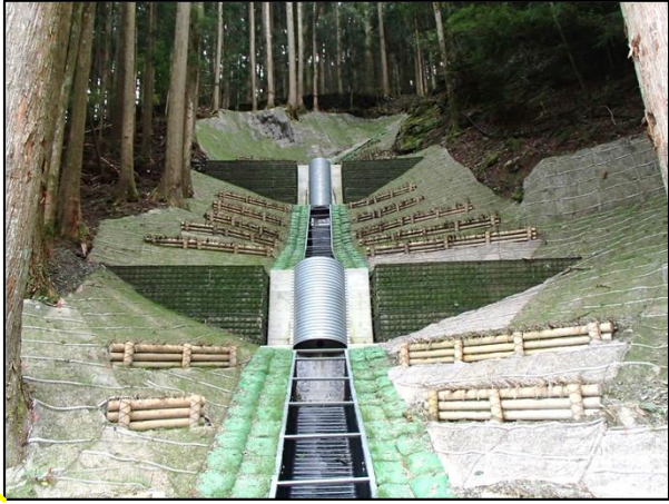
山腹工（水路工等）施工状況（令和3年）
