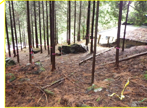
地すべり対策工（集水井工）施工前
