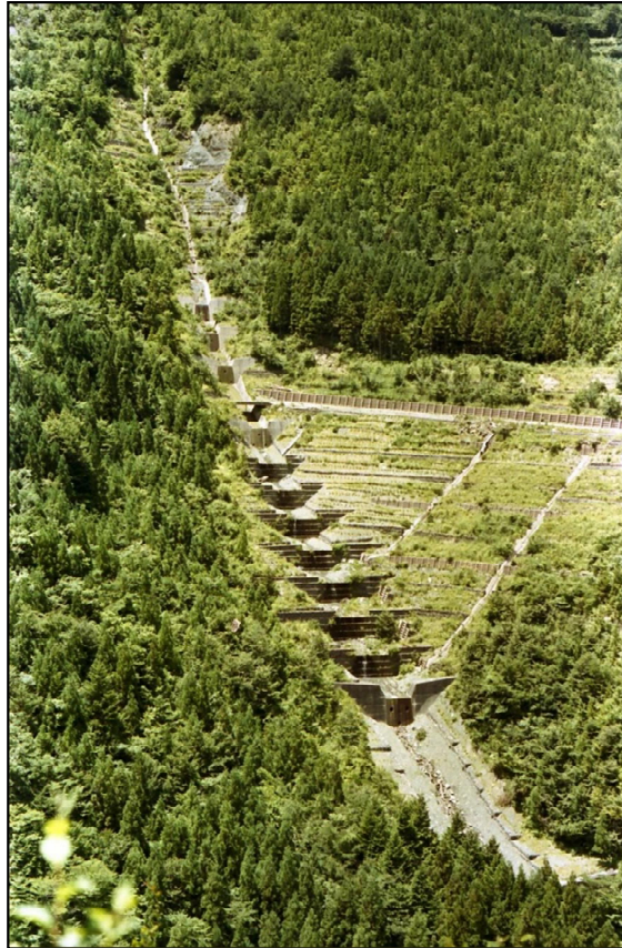
山腹工（土留工、水路工等）等 施工状況（平成26年）
