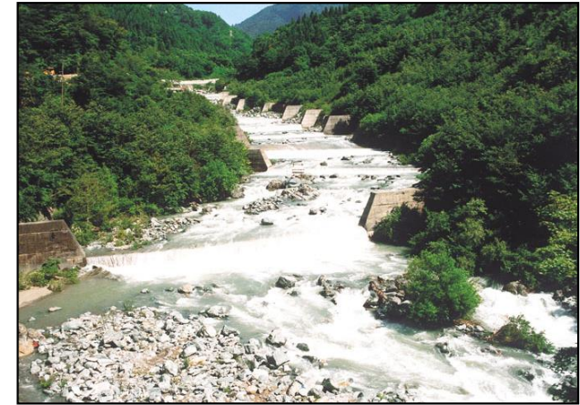
治山ダム(床固工)等 施工状況(平成10年)
