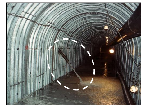
集水井の排水ボーリング
