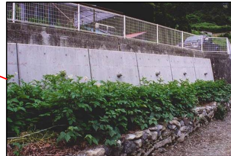
地すべり対策工（アンカー工）施工状況（平成12年）
