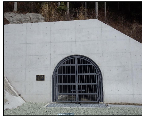
地すべり対策工 参考 (嶺北署沖(下)排水トンネル工)
