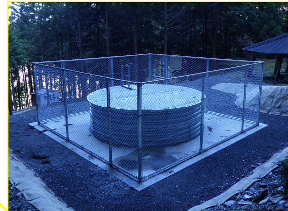
地すべり対策工（集水井工）施工状況（令和4年）
