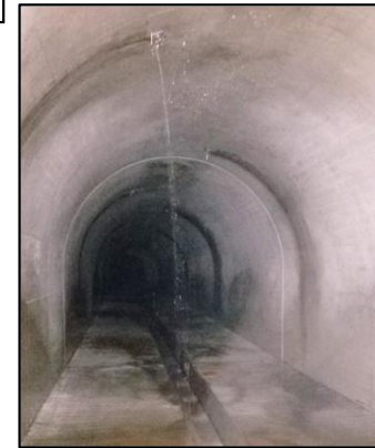
集水ボーリング
