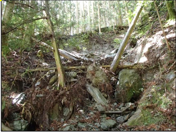
林内溪岸浸食状況 施工前
