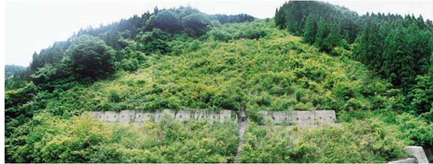
山腹工（水路工等）施工状況（令和元年）
