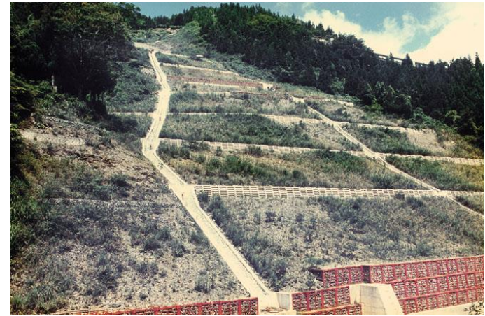
山腹工（土留工、水路工等）施工状況（昭和60年）
