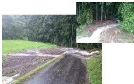
まんのう町の予防治山予定箇所 土砂が道路を越流して農地が被災
