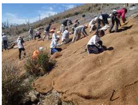
被害跡地に地域住民と連携して植生回復マットを設置している様子
