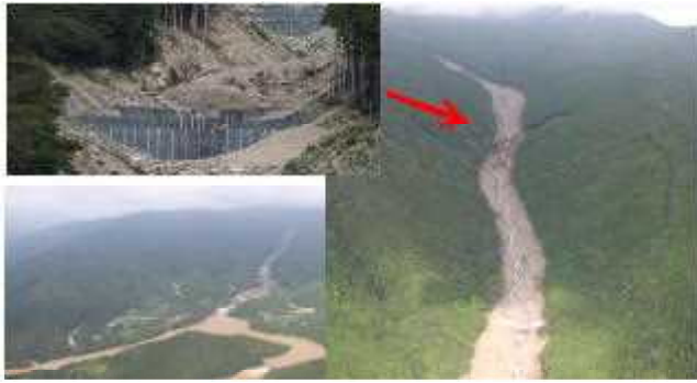
奈半利川地区の被災箇所（H23. 7）と 対策工（鋼製自在枠床固工）の施工状況（H27. 10）
