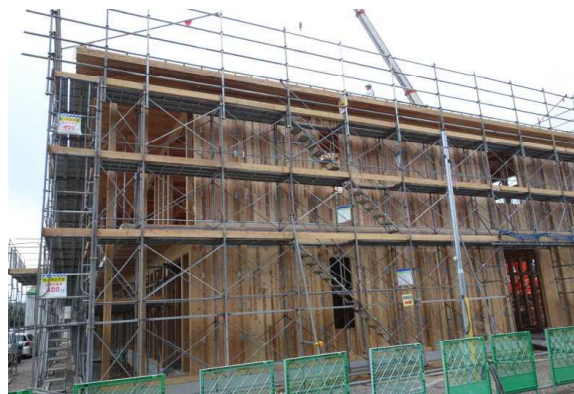
CLTによる事務所建設（高知県南国市）
