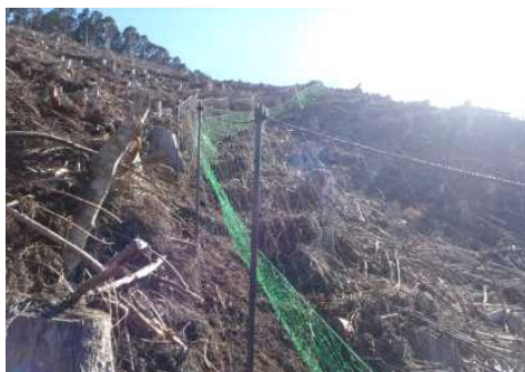
シカネットを設置した様子
