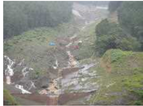
復旧工事完成直後の豪雨時の状況（H26. 8） （阿津江地区）
