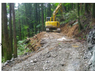
森林作業道開設
