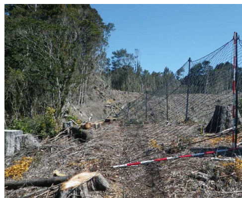
斜め張りのシカ防護柵（高知県北川村）
