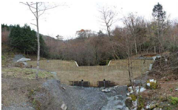
溪流荒廃地に木製残存型枠を使用し施工した谷止工（高知県土佐町）
