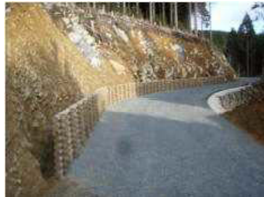
林道に施工した木柵工（愛媛県愛南町）
