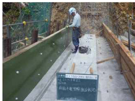
谷止工の木製合板型枠組立状況（高知県四万十市）
