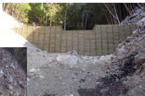
木製枠に栗石を充填した 谷止工（愛媛県愛南町）
