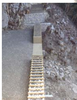
木製枠に栗石を充填した 谷止工（愛媛県愛南町）
