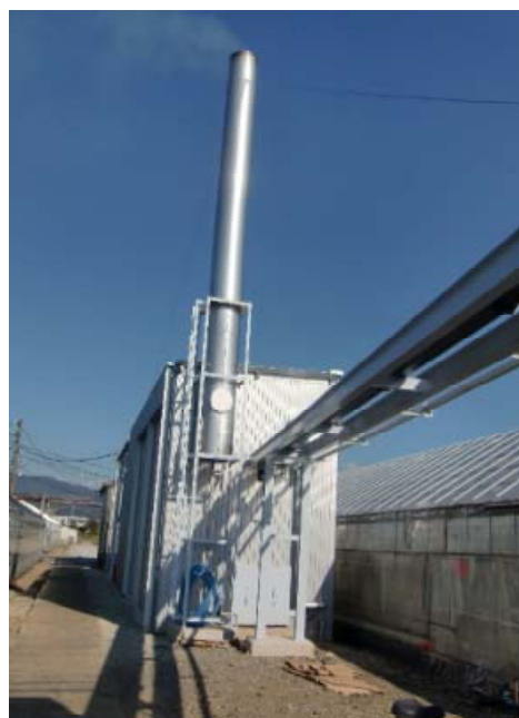
園芸ハウス(右)を暖房する チップボイラー (高知県南国市)
