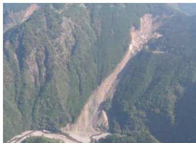
阿津江地区の崩壊地全景
