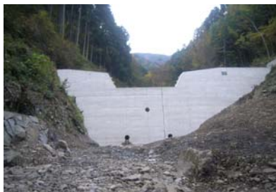
国有林内の谷止工施工状況
