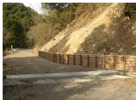
林道に施工した木柵工 （高知県四万十町）
