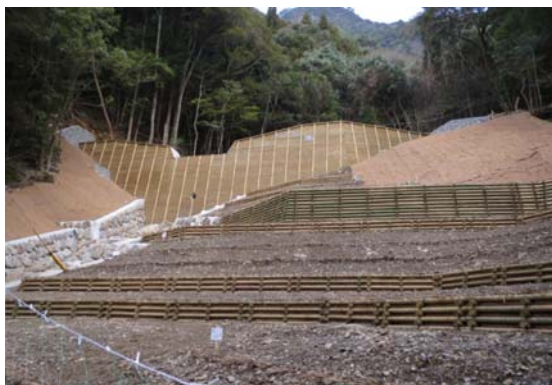
木製残存型枠を使用した谷止工及び崩壊地に施工した丸太土留工（高知県四万十市）
