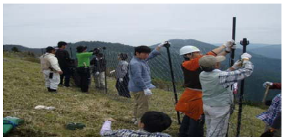
ボランティアとの協働による防護ネット柵設置(三嶺)
