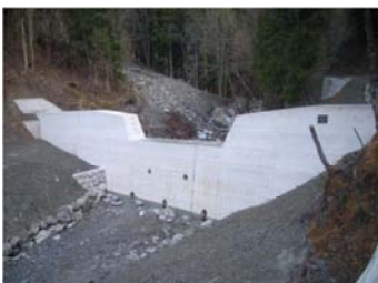
【谷止工の施工状況】
