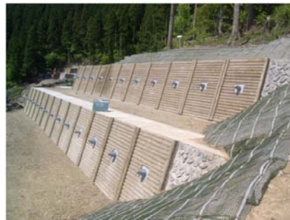
残存型枠を使用したアンカー工の受圧板 (高知県いの町)
