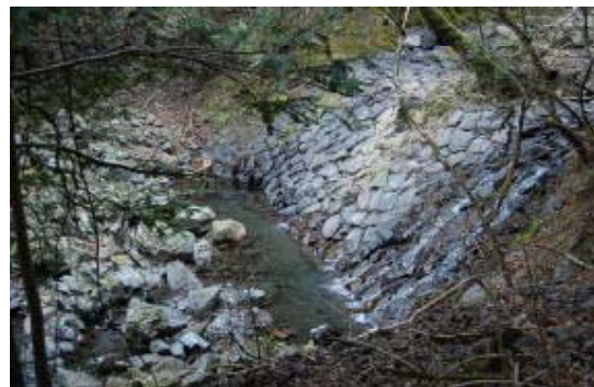
加奈木の崩えの練積堰堤
