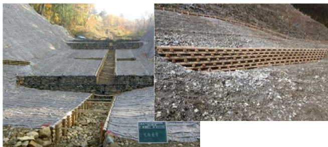
山腹崩壊地に施工した丸太水路工と丸太土留工 (愛媛県西条市、徳島県美馬市)
