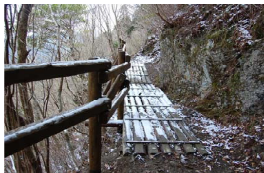
工石山の歩道 (嶺北森林管理署により平成22年度整備)
