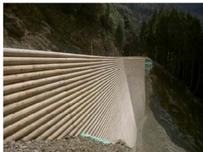
林道に施工した補強土壁工 (高知県北川村)
