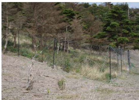
防護柵の設置状況（平成20年5月に設置。写真は同年9月の状況で、柵の内側は植生が回復。）
