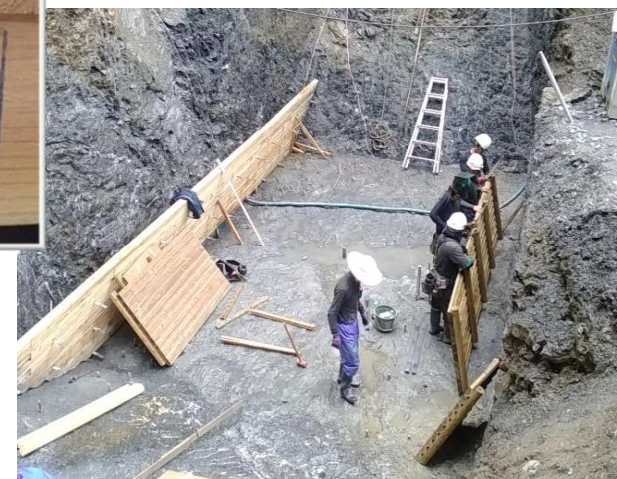
治山ダムの木製型枠 組立の様子
