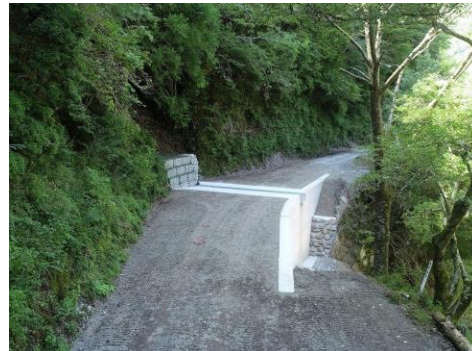
国有林林道の整備
