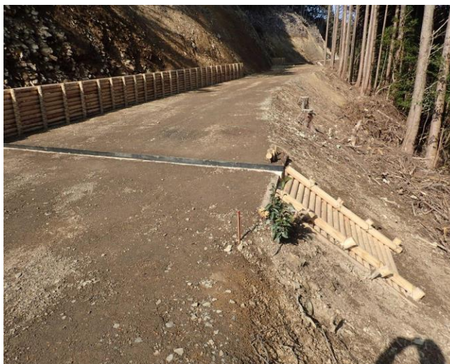
間伐材を使用した 木柵工 (もくさくこう) 木製横断溝 (もくせいおうだんこう) 木製吐口保護工 (もくせいはげぐちほごこう)
