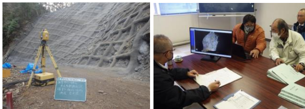
レーザスキャナを活用した出来形計測と検査 (四万十署)
