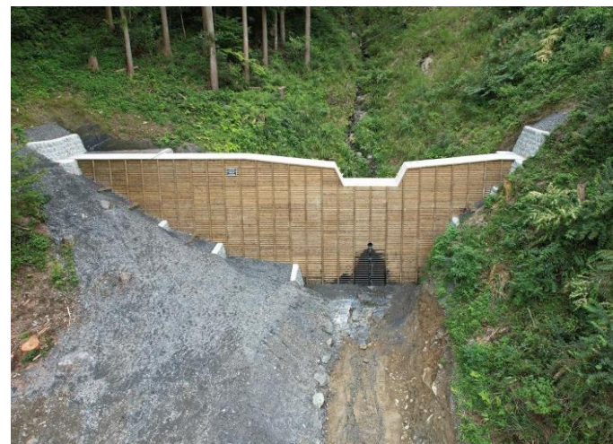
木製型枠を使用した 治山ダム
