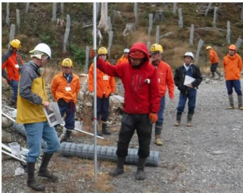
防護網と単木保護の新たな施工及びニホンジカの侵入抑制の検討会(高知中部署)
