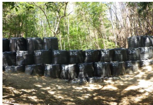
被災箇所の応急対策工事 (愛媛署)
