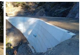
西川林道災害復旧工事 (魚梁瀬産業(有))
