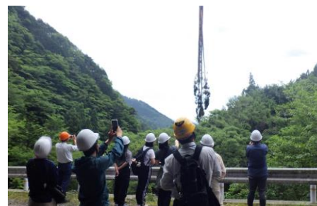
現地説明会(架線集材の見学)
