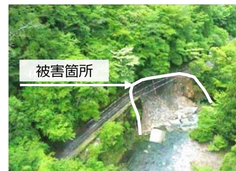
災害発生時の現地調査
