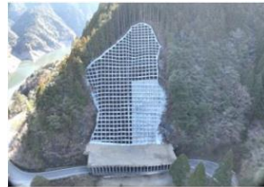
復旧治山工事
