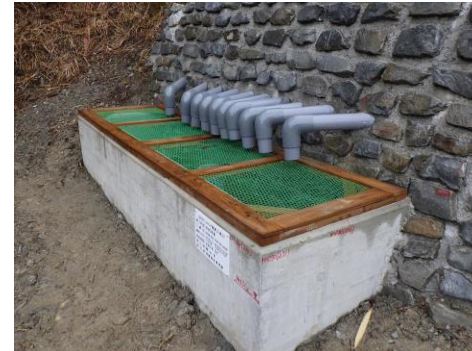
民有林直轄治山事業（祖谷川地区） (徳島県三好市)
