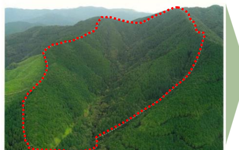
誘導伐実施前
