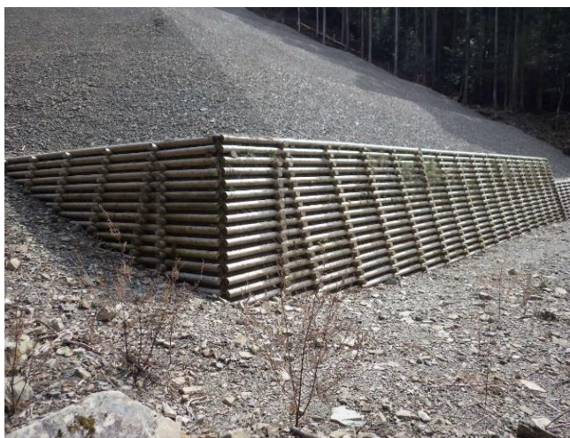
間伐材を使用した 木製校倉式土留工 (もくせいあぜくらしきどめこう)
