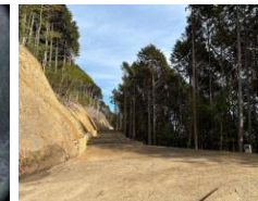
堂ヶ森林業専用道新設工事 (有)松元建設
