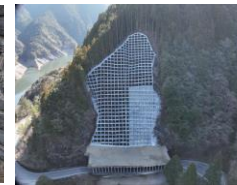
明善山(2087)復旧治山工事 (湯浅建設株式会社)
