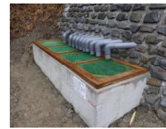
祖谷川地区麦生土(下)地すべり防止工事 (株式会社山全)
