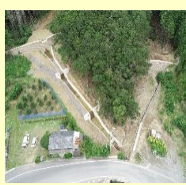
■被災復旧後のドローン空撮画像
