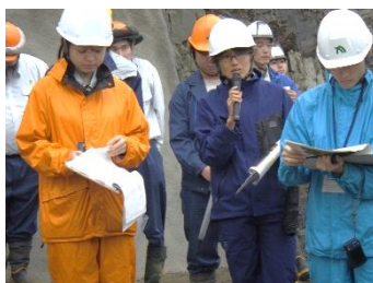
山腹工におけるICTを活用した 施工管理 (香川森林管理事務所)
