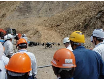
治山事業における大型ドローンを 用いた資材運搬 (嶺北森林管理署)
