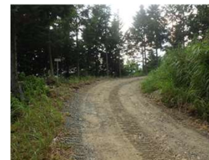
⑧▷ 迂回路として活用した国有林林道
